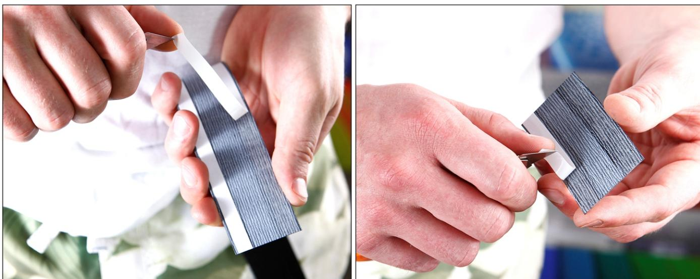
**17** Подведите к углу и движением снизу вверх установите декор к профилю. Такие действия производите по всему периметру.
