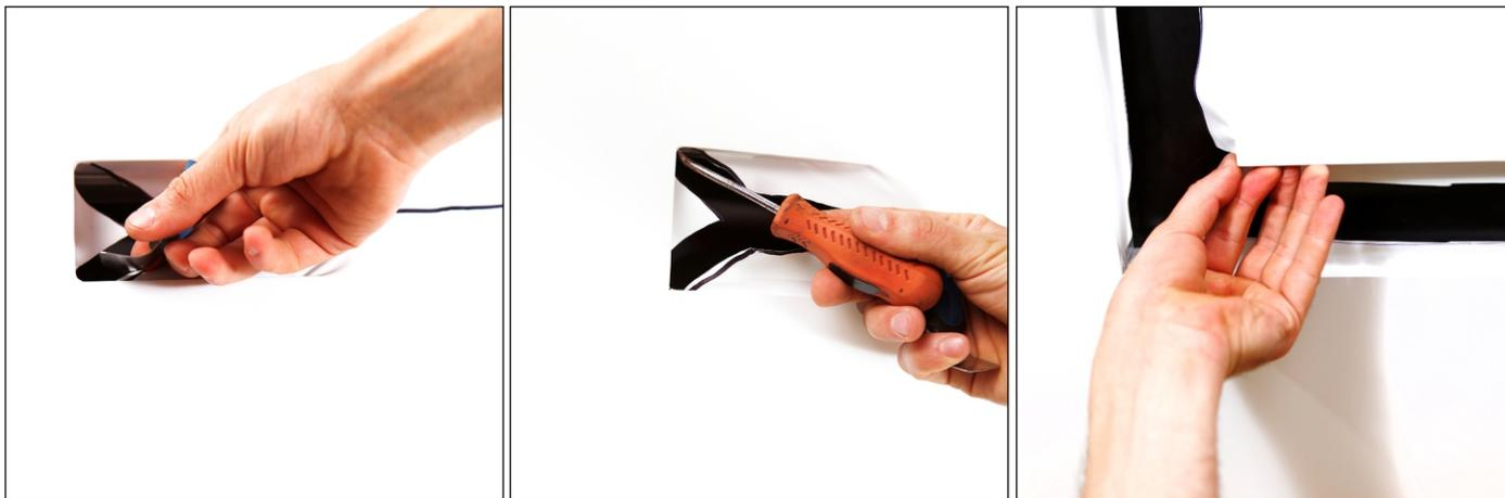
**11** Закатайте роликом фиксирующий шнур в камеру конечной фиксации. В процессе монтажа фиксирующего шнура прогревайте его феном. Остатки полотна аккуратно срежьте.
