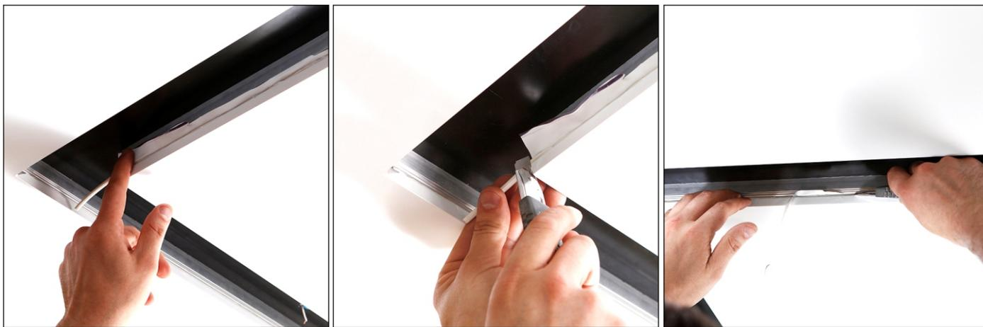
**12** Обработайте спиртом (обезжирьте) часть смонтированной пленки и верхнюю часть алюминиевого профиля.
