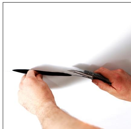
**10** Для фиксации пленки на углах сделайте разрез пленки по биссектрисе угла, отступив от профиля 3мм. Одновременно перегните обе стороны пленки и зафиксируйте на клеевую основу. Для дополнительной фиксации угла нанесите небольшую каплю клея монтажным крючком непосредственно на область стыковки профиля на углу и при помощи монтажного крючка и монтажной лопатки прижмите материал к профилю. Это позволит сформировать четкий угол 90°.
