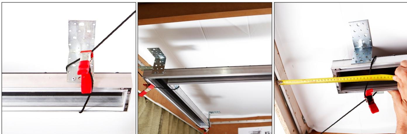
**4** Установите нишу на основном потолке согласно дизайн-проекта и уровню стенового профиля, заведённому по периметру помещения. При больших площадях рекомендуется производить монтаж на гибких консолях (перфопластина) во избежание искажения-линзирования плёнки после монтажа.
